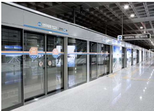
도표 40. 지하철 승강장안전문(PSD) 시스템 (반밀폐형)
